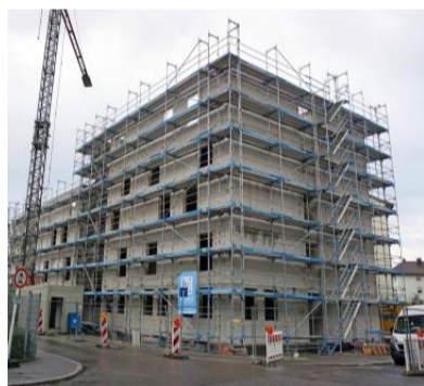
Die Aufbaugilde baut zwei Gebäude für ihre Wohnungslosenhilfe. Foto: privat
