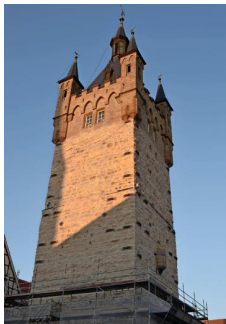
Ob die Turm-Gründung frostfrei ist, wird zum Sanierungsende geprüft. Foto: Pfäffle
