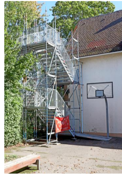
Die Fluchttreppe von außen: Sehbehinderte kämpfen mit den Gitterstufen.
