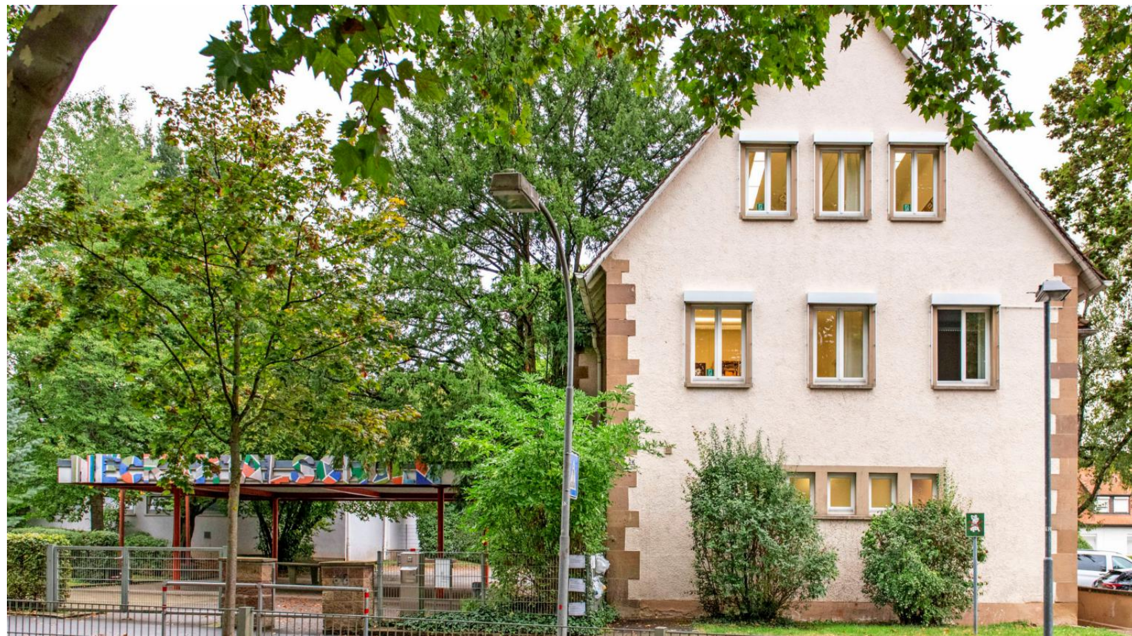
Die Neckartalschule in Böckingen ist aktuell die Schule mit der schlechtesten Bausubstanz. Nach dem Abriss ist am Standort ein Neubau geplant.
